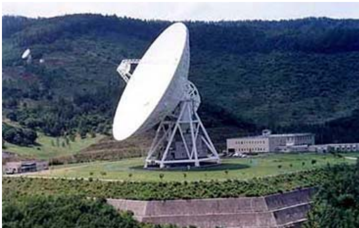
64mパラボラアンテナ JAXA 臼田宇宙空間観測所 X-band(8GHz), S-band(2GHz)
