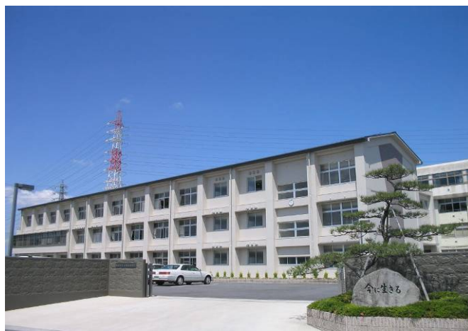
Fig.1 愛知県日進市立日進西中学校
